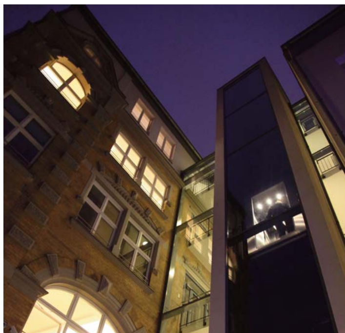
Das IPV-Gebäude in Berlin
